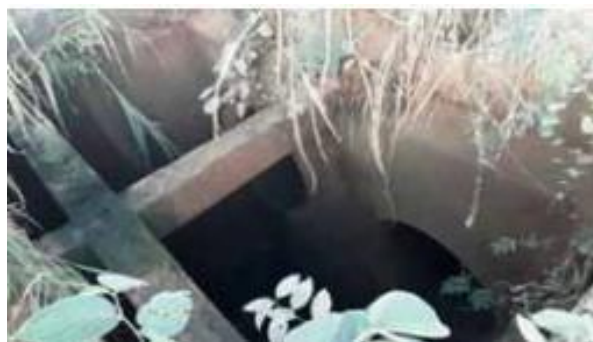
Figura 1.8 - Tubulação de entrada da caixa de drenagem na margem direita da nascente do Ribeirão Tibiriçá
