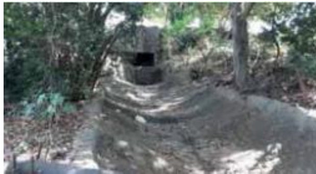
Figura 2.1 - Dissipador na margem direita da nascente do corpo hídrico, na esquina da Rua Antenor Lara Campos com a Rua Severino Hermínio Barbosa
