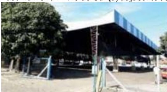
Figura 1.2 - Área impermeabilizada na Feira Livre de Garça, adjacente ao corpo hídrico
